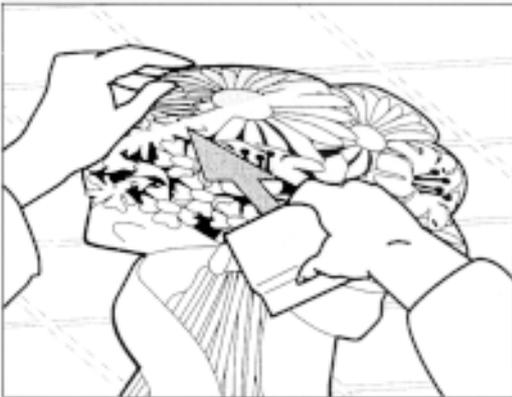
6. Heftpunkte an den Folienkanten vor dem Anraken des Randes lösen, um Falten auszuschließen.
